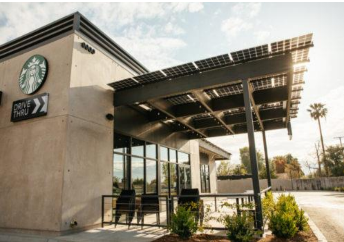
캘리포니아 로스앤젤레스 노스리지 지역의 스타벅스 새 매장에 설치된 태양광 패널
